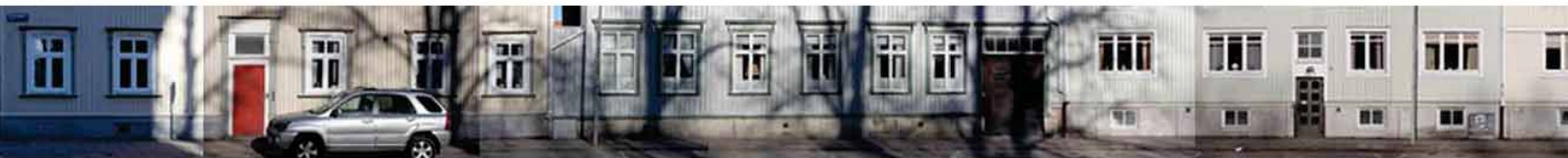
Exempel på en fasad med stora kulturhistoriska värden: Kvarteret Furan längs Drottninggatan.
